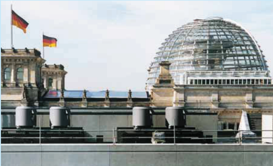
Entrauchungs-Dachventilatoren Typ BVD 710/30-6 - F 400
