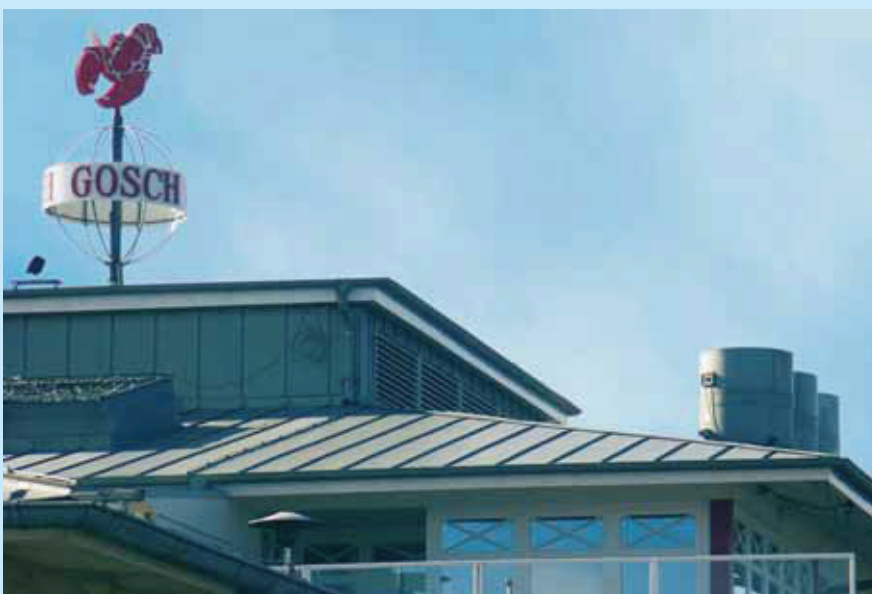
Dachventilatoren Baugröße 630 mit Schalldämpfhauben SDV (Fisch-Restaurant auf Westerland/Sylt)
