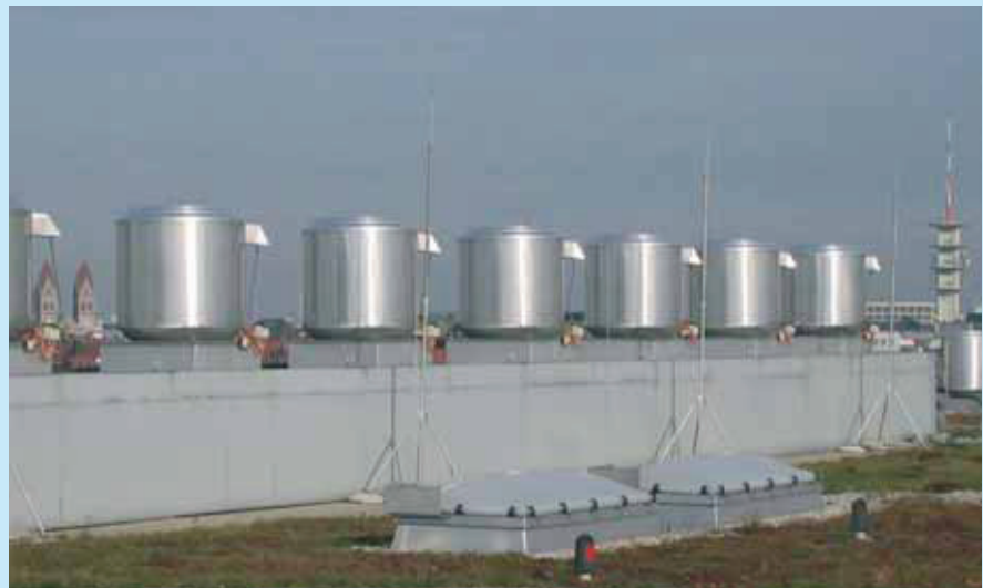
Entrauchungs-Dachventilatoren BVD 710 - F 600 (Daimler-Chrysler Niederlassung München)
